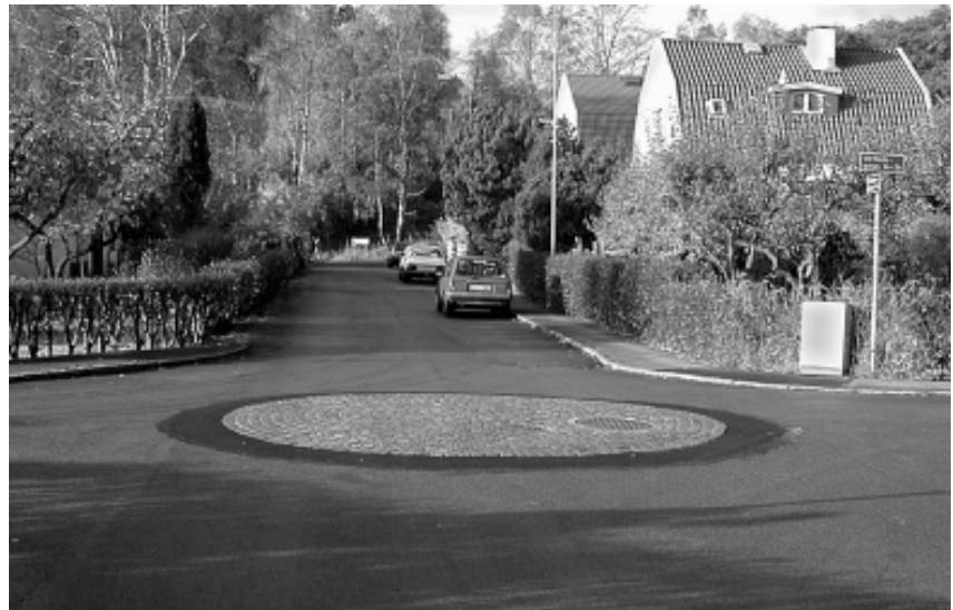
Väglins (upphöjd cirkelyta) utplacerad i korsning mellan två lokalgator i Bräcke.
